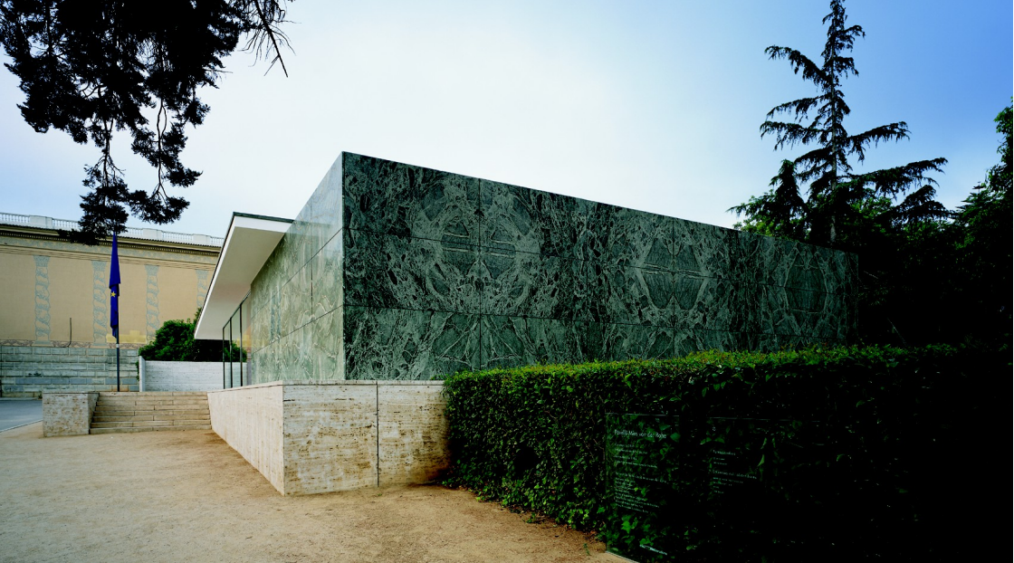
Fig. 8 – Mies van der Rohe, Padiglione di Barcellona. In primo piano, in marmo verde di Tino sul bianco crepidoma in travertino, la parete del sacello che racchiude la vasca interna e la statua di Georg Kolbe. (© Pepo Segura – Fundació Mies van der Rohe)
