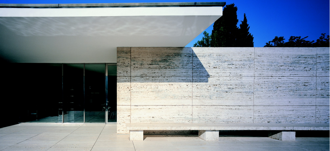
Fig. 7 – Mies van der Rohe, Padiglione di Barcellona. Dettaglio dell'ingresso al volume dei servizi e della sottile lastra di copertura, apparentemente appoggiata alla parete perimetrale in travertino. (© Pepo Segura – Fundació Mies van der Rohe)
