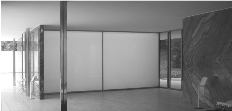
Fig. 11 – Mies van der Rohe, Padiglione di Barcellona. La parete-lampada traslucida, controcampo sull'ingresso. La luce, naturale e artificiale, viene usata come materia architettonica, contribuendo a generare uno spazio indefinito e non confinabile. (Foto dell'autore)
